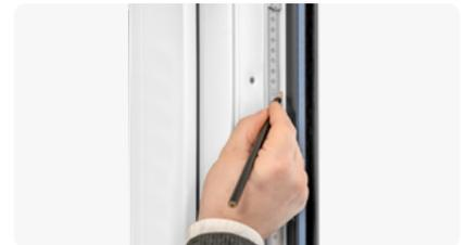
9.) Nun wird mittig im senkrechten Bereich, je rechts und links 150 mm der Fensterrahmendichtung weggeschnitten oder komplett entfernt. Werden zwei Lüfter montiert, werden pro Seite 300 mm Dichtung entfernt oder weggeschnitten.
