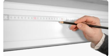
2.) Die Bohr- und Schneidschablone beim Schließen des Fensters zwischen Fensterrahmen und Fensterflügel klemmen, so dass der mittlere Bohrkanal auf der Markierung liegt. Werden zwei Lüfter montiert, wird die Bohr- und Schneidschablone mit einem Ende an der Markierung angelegt. Nachdem der erste FensterLüfto® mit den kommenden Montageschritten montiert ist, wird die Schablone am montierten Lüfter angelegt und wieder mit Schritt 3 begonnen.
