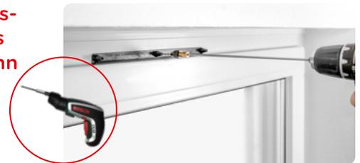
4.) Die Enden der Bohr- und Schneidschablone werden mit einem Bleistift oben auf dem Fensterflügel markiert (wichtig für Schritt 6). Nun wird das Fenster geöffnet und die Schablone beiseitegelegt.
