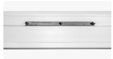
3.) Vor dem Vorbohren durch die Bohrkanäle, ist es erforderlich zu prüfen, ob die Schablone exakt auf dem Fensterflügel aufliegt. Nun wird mit einem 3mm-Bohrer vorgebohrt.
