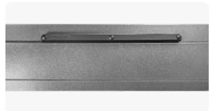
9.) Die Mitteldichtung muss nicht komplett entnommen werden. Lediglich die Fahne der Mitteldichtung wird mit einem scharfen Cuttermesser gegenüber des FensterLüfto® auf Lüfterlänge weggeschnitten.
