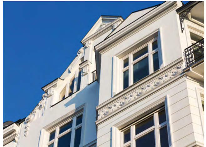
Auch für Denkmalschutz geeignet
